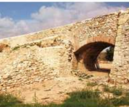
Restauració Pont de les Caixes Constantí
